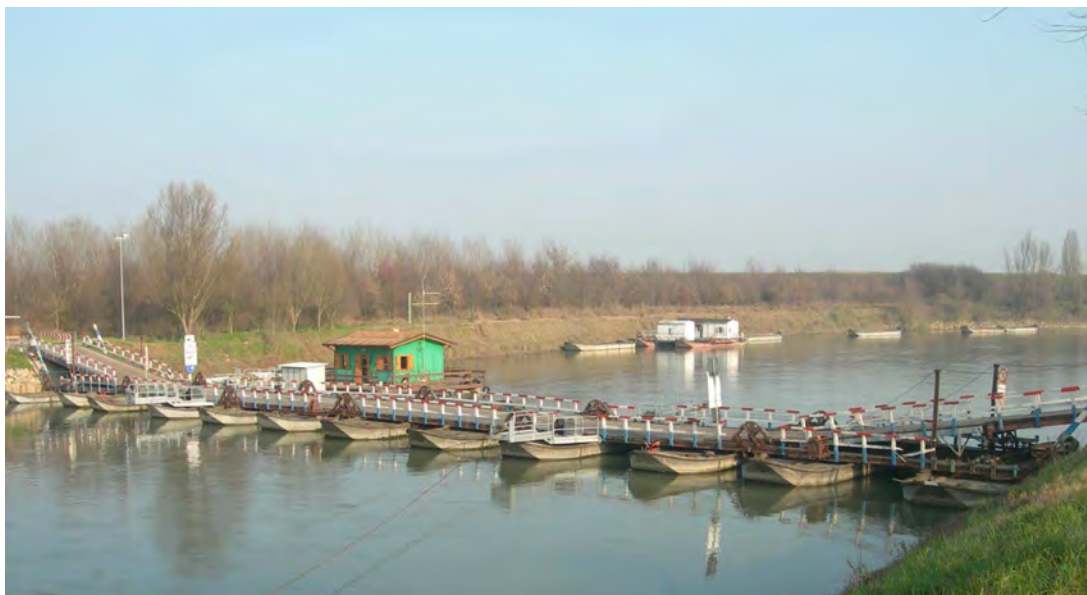
Figura 23 – Il ponte di Barche di foce Oglio, appena prima dell'immissione in Po. Tre rampe permettono di aggiustare questo ponte mobile in relazione alle variazioni di livello del fiume (Fonte: E. Racchetti et al.).
